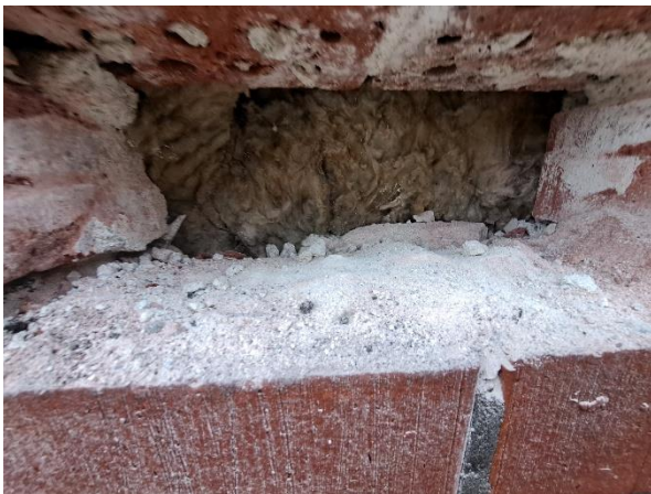
Kuva 35. Etupihan puolella ulkoseinän eristeenä kivivillaa.
