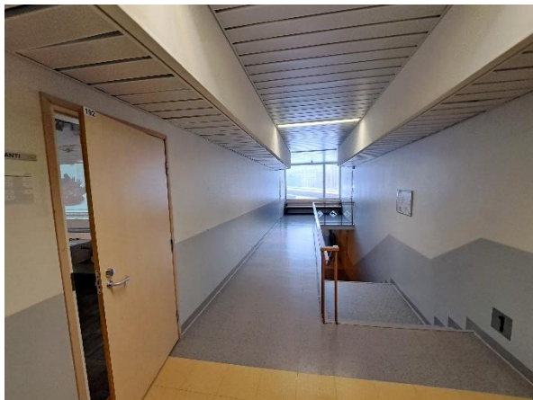
Kuva 21. Käytävälle on asennettu vinyylilaattapinnotteet vuonna 2017.
