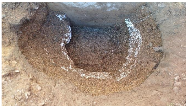
Kuva 9. Sokkelin vieren kaivaus kotitalousluokan vierellä: antura.
