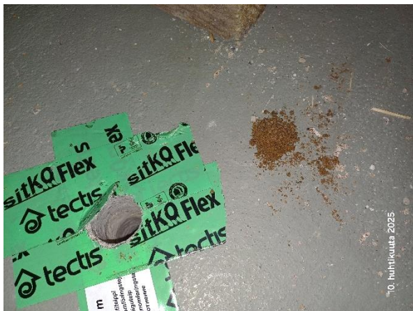
Kuva 23. Alapohjan rakennetarkistusporaus maanvarainen betonilaatta. Alla hienoa hiekkaa.
