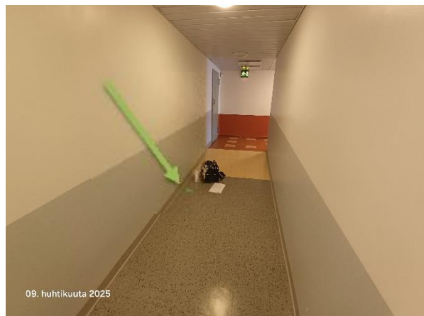
Kuva 29. Käytävän viiltomittaus pinnoitteen alta kotitalousluokan edestä.
