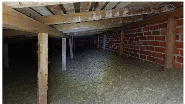
Kuva 54. Ruokalan yläpuolisen yläpohjatilan yleiskuva, ei erillistä aluskatetta vesikatteen alla
