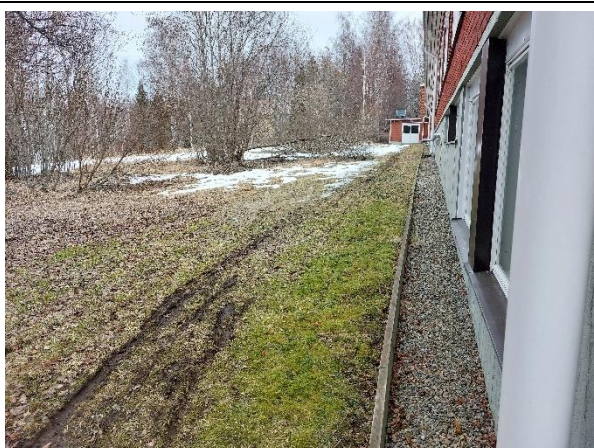
Kuva 5. Luokkasiiven takapihan puolella nurmikkoa. Sokkelin vierellä sorastus.
