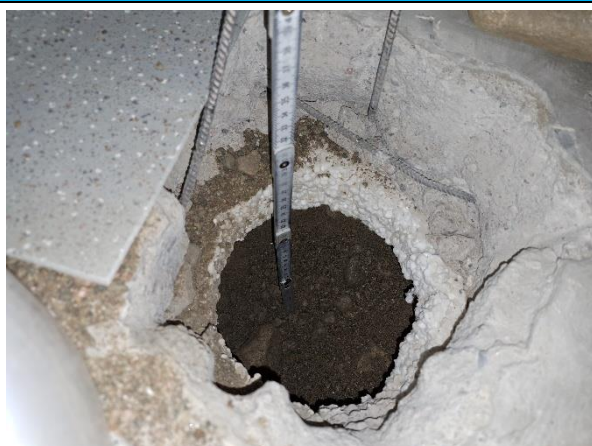
Kuva 20.3 Yleiskuva alustäytön kiviaineesta
