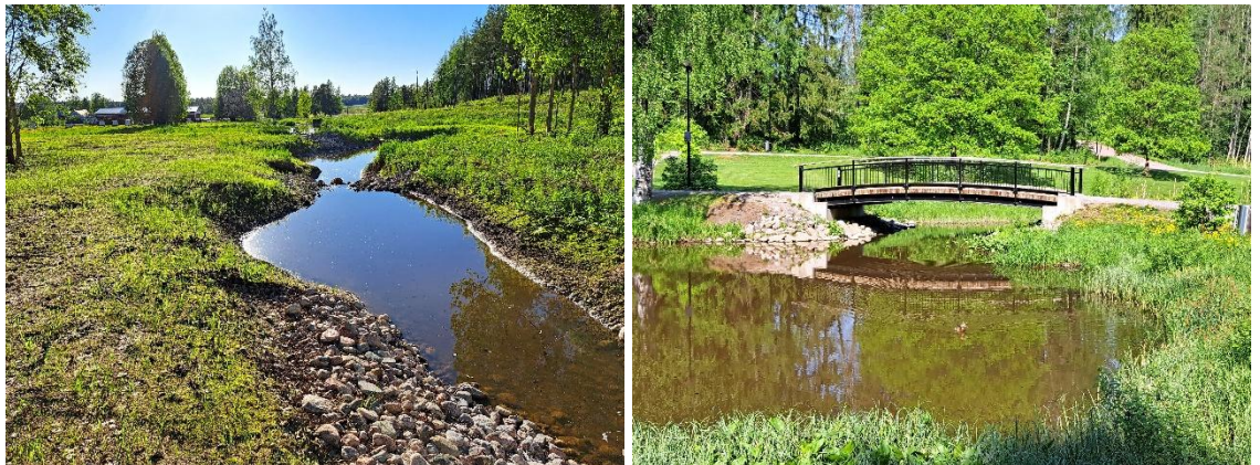
Kuva 11. Esimerkkikuvia hulevesialtaasta © Destia Oy 2025.
