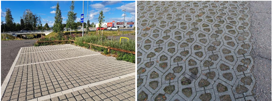
Kuva 10. Esimerkkikuvia vettä läpäisevistä pintamateriaaleista © Destia Oy 2025.
