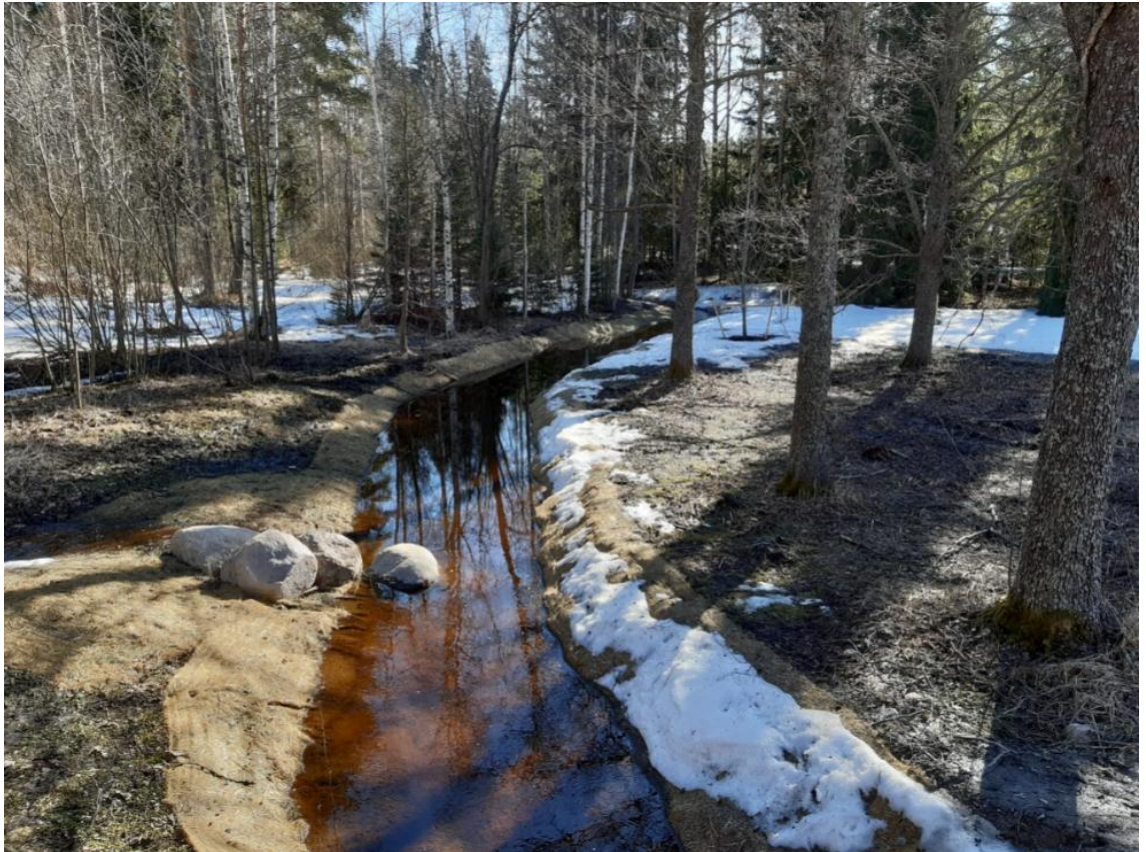
Kuva 13. Esimerkkikuvia eroosiosuojamatolla suojatusta ojasta © Destia Oy 2025.
