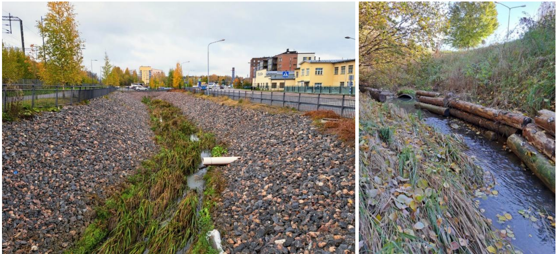
Kuva 12. Esimerkkikuvia tulvareitteinä toimivista ojista ja eroosiosuojauksista © Destia Oy 2022.
