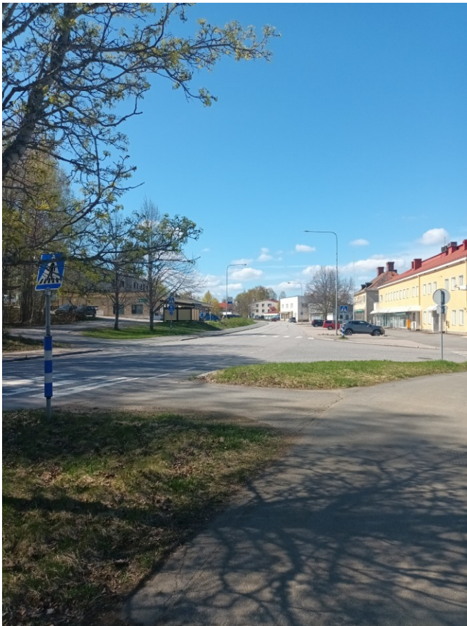
KUVA 5. Selvitysalueen rakennettua ympäristöä. Kuvassa Keskustie.
