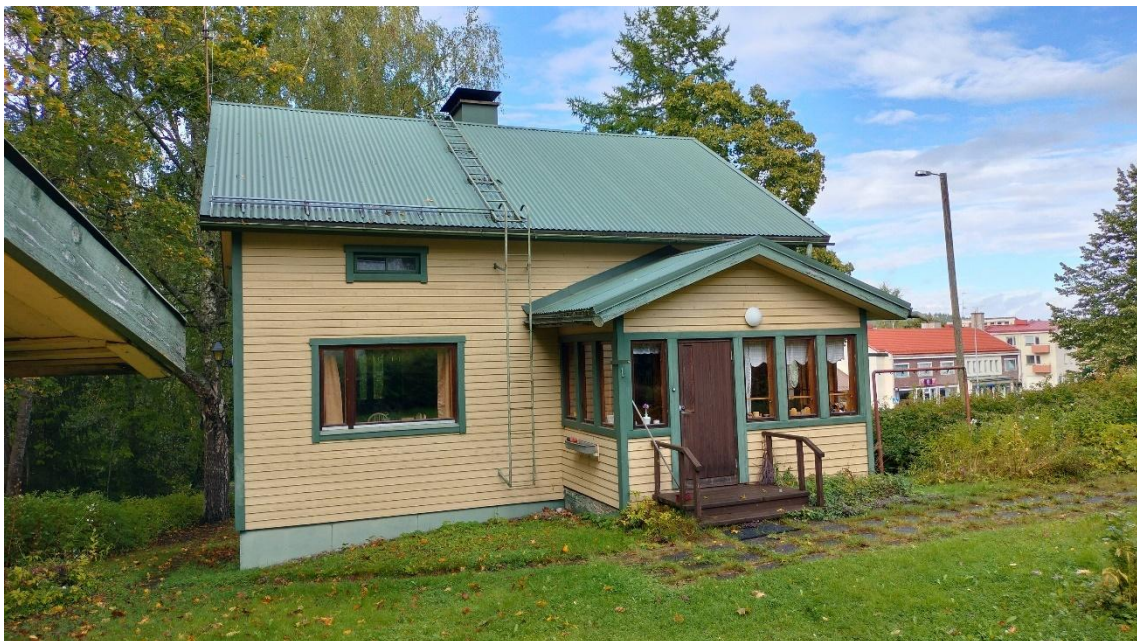
Kuva 44 Padasjoen kirkonkylällä on säilynyt myös jälleenrakennuskauden tyyppipiirustusten mukaan rakennettuja asuinrakennuksia. Kyseinen asuinrakennus sijaitsee Metsotiellä. Kuvan oikeassa laidassa taustalla näkyy Pankkilan talo vuodelta 1957.
