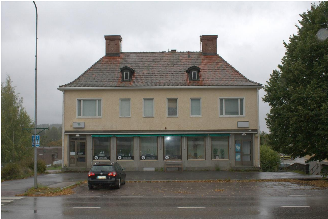
Kuva 28 Osoitteessa Keskustie 18 sijaitseva Yhdyspankin rakennus on säilynyt hyvin alkuperäisessä 1950-luvun ulkoasussaan. Rakennus on rakennettu vuonna 1953 arkkitehti Jaakko Tähtisen tyyppipiirustusta mukaillen.
