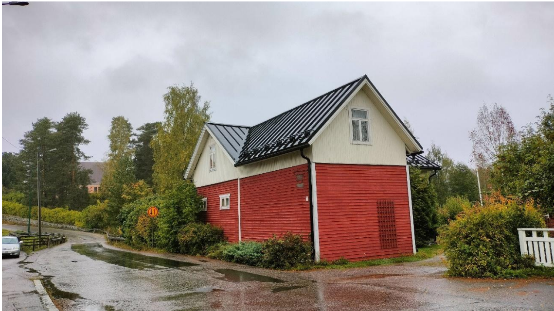
Kuva 38 Kellosalmentie 11:ssä sijaitseva asuinrakennus. Rakennus on alun perin rakennettu 1800-1900-luvun vaihteessa, mutta sen ulkoasu on muuttunut vuosien varrella.
