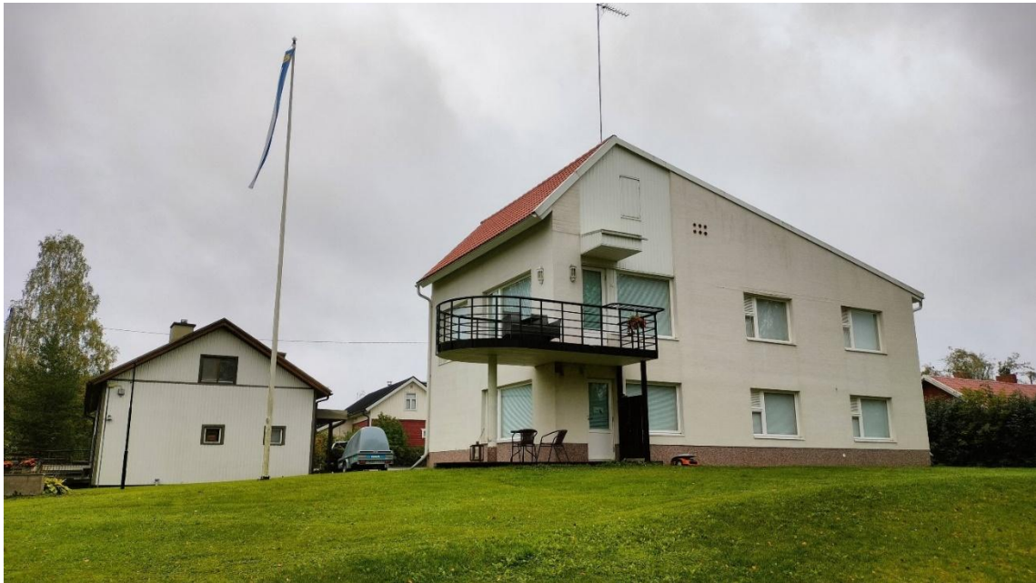
Kuva 57 Moderni omakotitalo Kellosalmentieltä 1990-luvulta. Kuvan vasemmassa laidassa oleva entinen leipomo on peräisin 1930-1940-luvulta, ja taustalla näkyvä punavalkoinen asuinrakennus 1800-luvun ja 1900-luvun vaihteesta.
