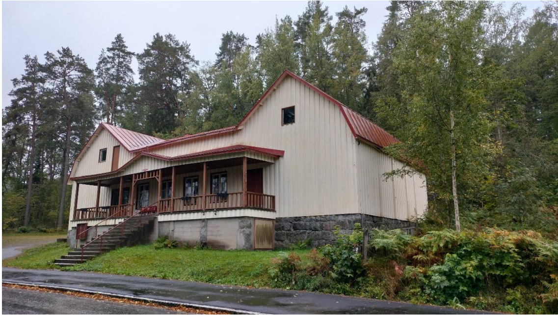
Kuva 40 Jokioisten työväentalo vuonna 2025. Pääjulkisivulta on tukittu ikkunoita ja vanhoja parvekkeenovia. Julkisivu on vuorattu vaalealla lomalaudoituksella.
